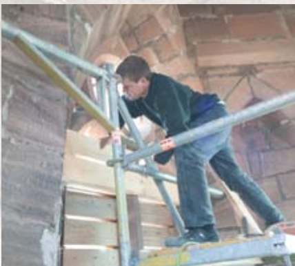
11. März - Einbau der Schallläden im Südturm
