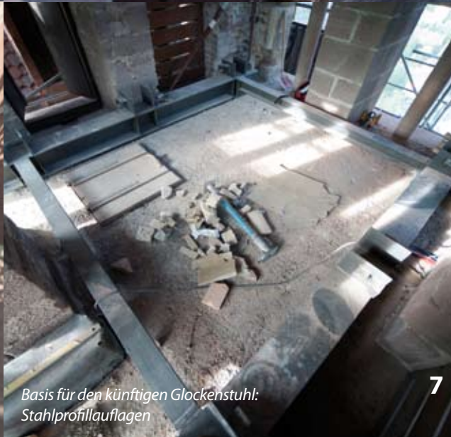
Unterer Ringanker an der Außenmauer
