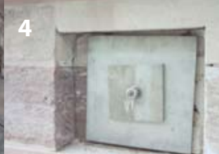
Acht Ankerbolzen werden die Schwingungskräfte der Glocken aufnehmen. Hier eine offene und eine verschlossene Ankerbolzen
