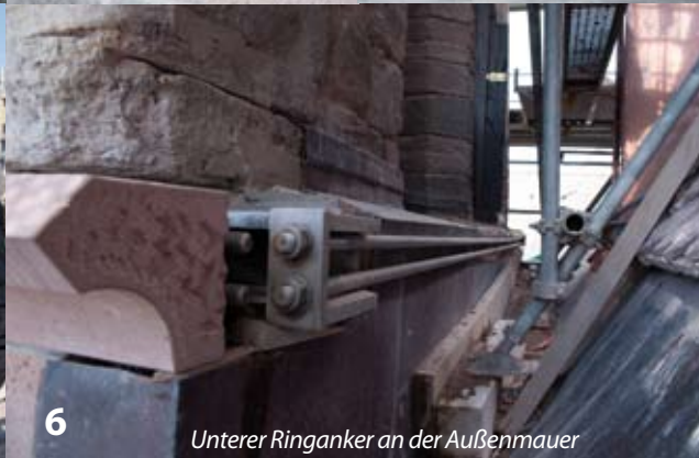
Acht Ankerbolzen werden die Schwingungskräfte der Glocken aufnehmen. Hier eine offene und eine verschlossene Ankerbolzen
