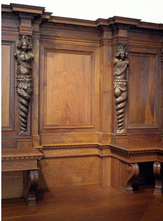
15 Ecksituation während der Rekonstruktion des Türrückganges, Zustand 2005
