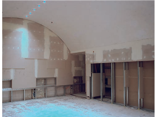
13 Östliche Längswand mit Ausneh- mung im Trockenbau zur Aufnah- me der Unterkonstruktion
