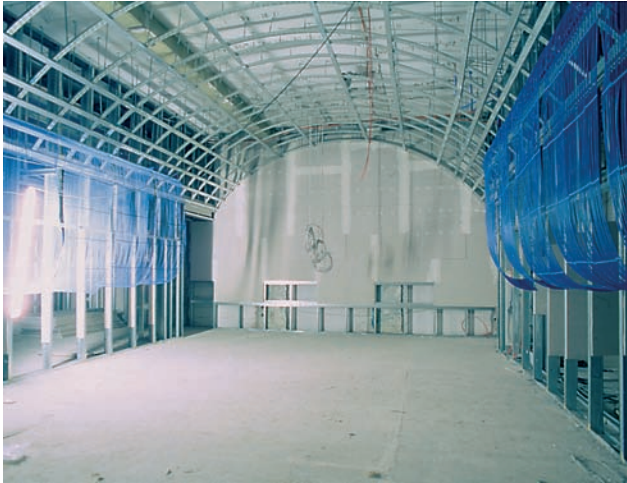
12 Erstellung der Raumarchitektur mit Blick zur Nordseite und dem Rund- gangdurchlass
