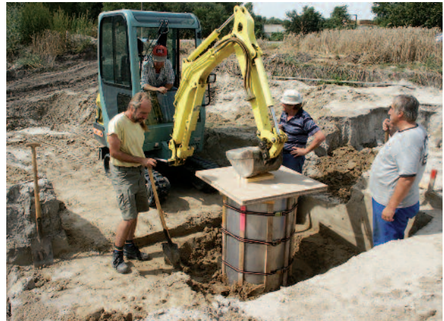
5 Das Einpressen des Stahlzylinders mittels Minibagger
