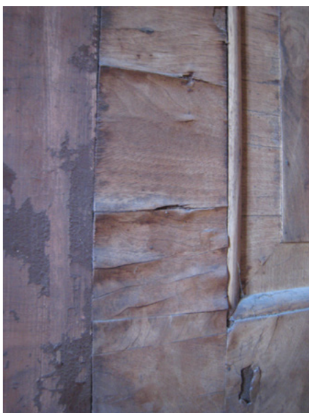
8 Intarsienkabinett, diverse Furnierabhebungen an Täfelungsteilen vor der Restaurierung
