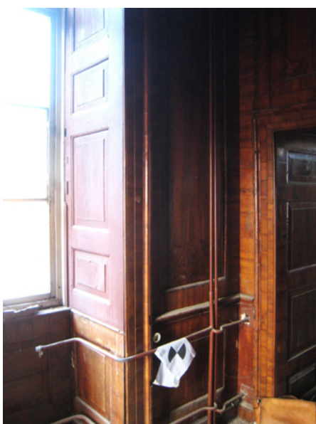
10 Intarsienkabinett, Elektroinstallationen und Heizungsrohre, die durch die Paneele verlegt wurden, Ausbrüche an der Verkleidung, braun gestrichene Wange der nördlichen Fenstereinfassung
