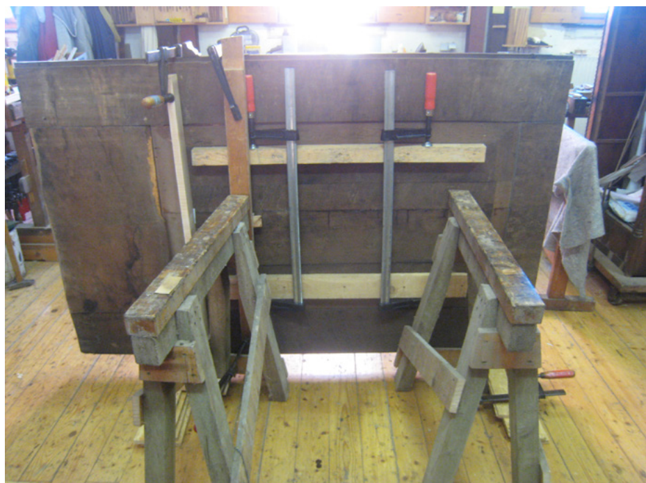
12 Intarsienkabinett, Verleimung der großen Schwundrisse in den Füllungen der Vertäfelungen
