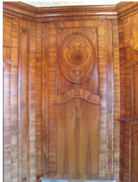
14 Intarsienkabinett, neutrale Ergänzung der fehlenden Füllung in der südöstlichen Wand
