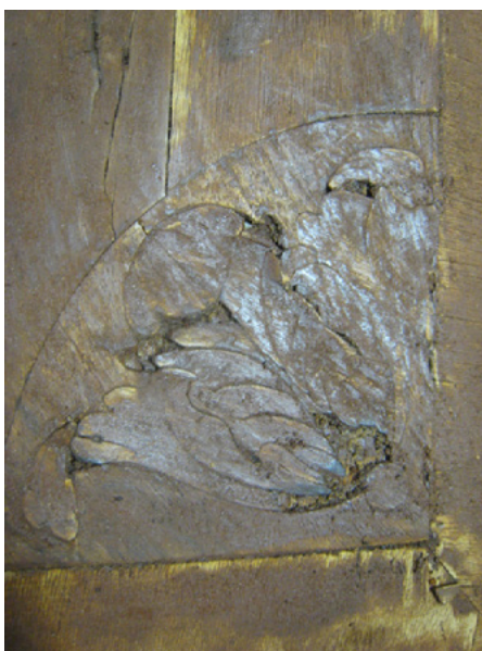
9 Intarsienkabinett, aufgeworfene Furniere an einem Blumenornament der Fensterläden
