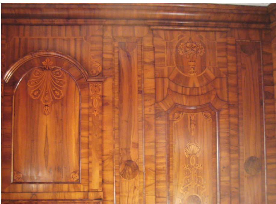
6 Intarsienkabinett, Wandvertäfelung mit Blumengebinden, Fruchtkörben, stilisierten Blattranken und Rocailles, die von Bandelwerk gerahmt werden, nach der Restaurierung
