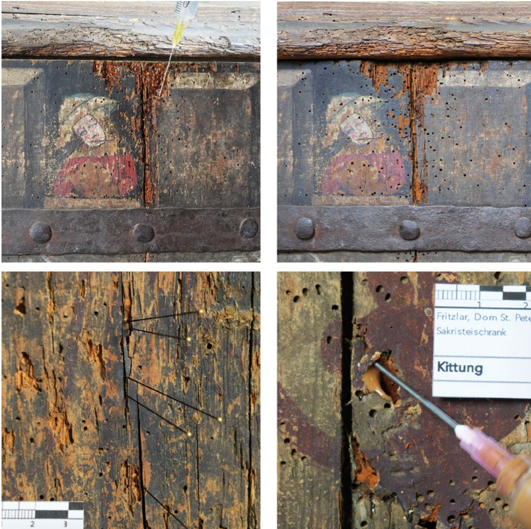
Abb. 6: Maßnahmen Holzfestigung (links), Metallreinigung und Kittung (rechts), 2025 Foto: Conservation Pool
