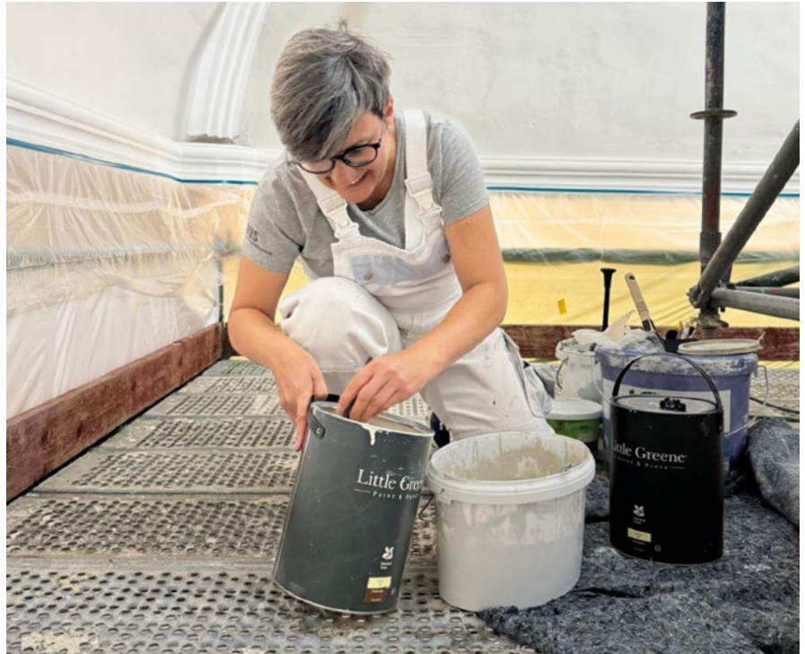
Abb. 2: Auf der Baustelle Die Malermeisterin Susanne Haus Foto: privat
