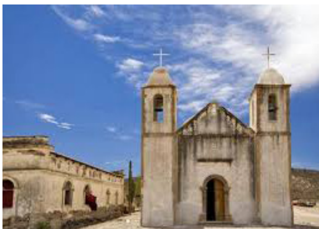
Fig. 1: Autor desconocido, Misión de San Luis Gonzaga Chiriyáquí (1737). Edificio construido bajo la autoridad del padre Juan Jacobo Baegert en la Antigua California. Imagen tomada de: https://culturabcs.gob.mx/recinto/56
