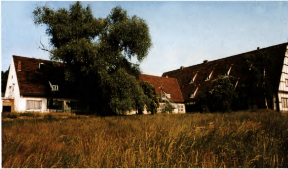
2 Ostfildern-Nellingen, Fliegerhorst, „Nellingen Barracks“, ab 1937 errichtet. Zustand 1998. Foto: DOMO GmbH, Balingen.
