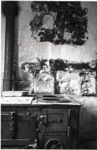
2 VELLBERG, Kreis Schwäbisch Hall, Im Städtle 29 (1584 d), verrußter Wandabschnitt einer Flurküche, unten: Steinfassung der Hinterladeröffnung, oben: Rauchführungslöcher.
