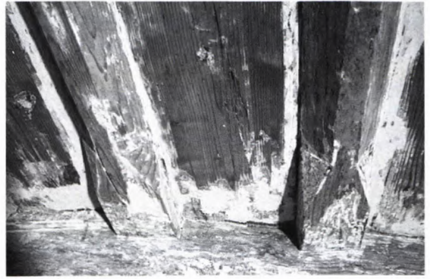
5 ESSLINGEN, Obertorstraße 74 (1349 d). Auflagerbereich einer Bretter-Balken-Decke.
