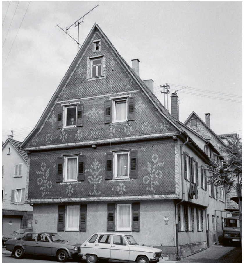
5 Schmuckgiebel in der Zwerchgasse 6, um 1978. Bei der Neueindeckung wurde der Dekor nicht wiederhergestellt.
