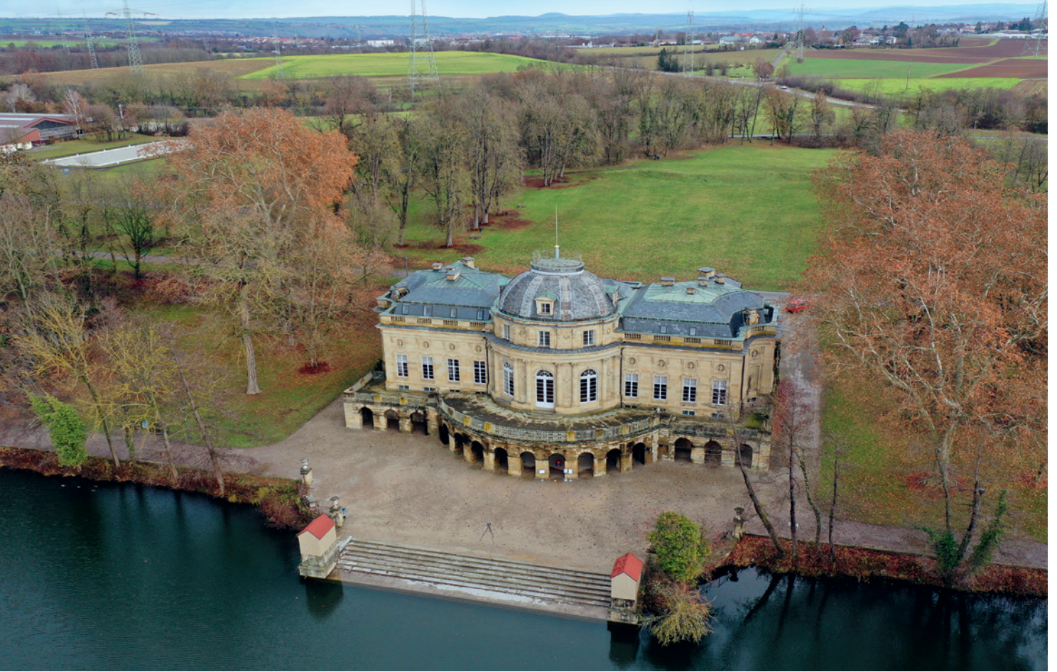
6 Luftbild der Schlossanlage von Süden.
