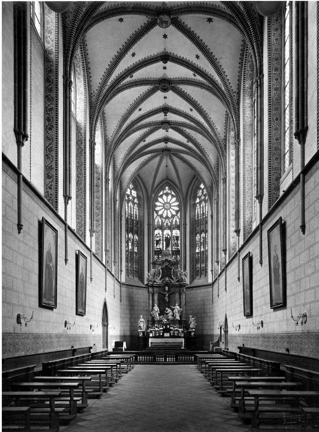
il. 11 Wnętrze kościoła św. Wojciecha we Wrocławiu po remoncie z lat 1915–1919, widok na prezbiterium z barokowym ołtarzem św. Krzyża, fot. archiwalna, Herder-Institut, Marburg, Bildarchiv, sygn. 130.447
